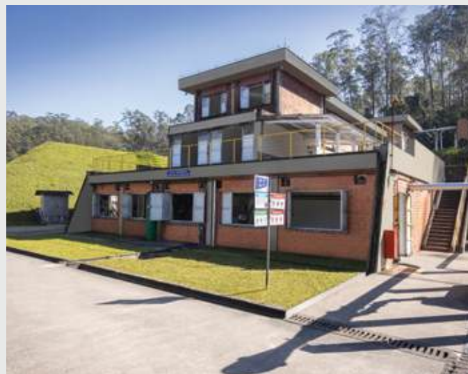
Fábrica de Pólvora CBC Ribeirão Pires - SP
